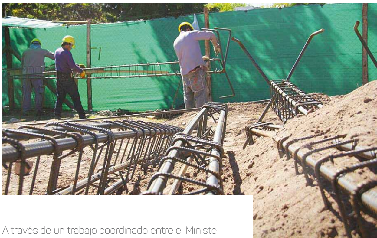
Se trabaja con todo en la obra.
