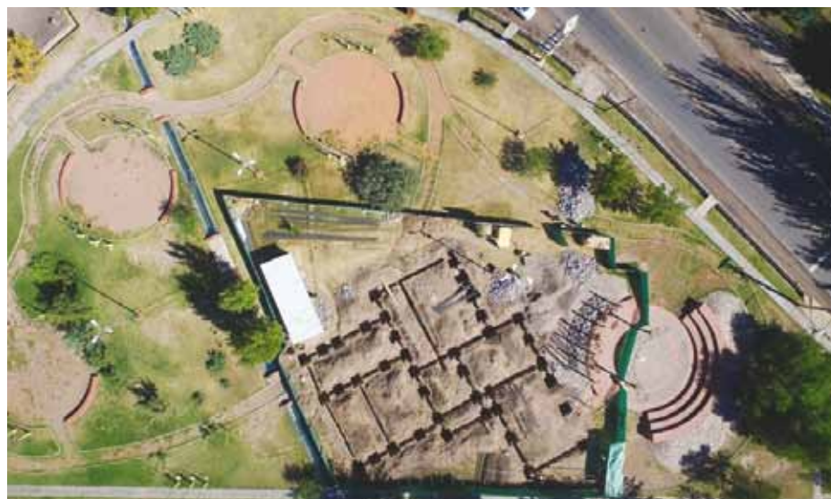
Vista aérea de la novedosa construcción.
