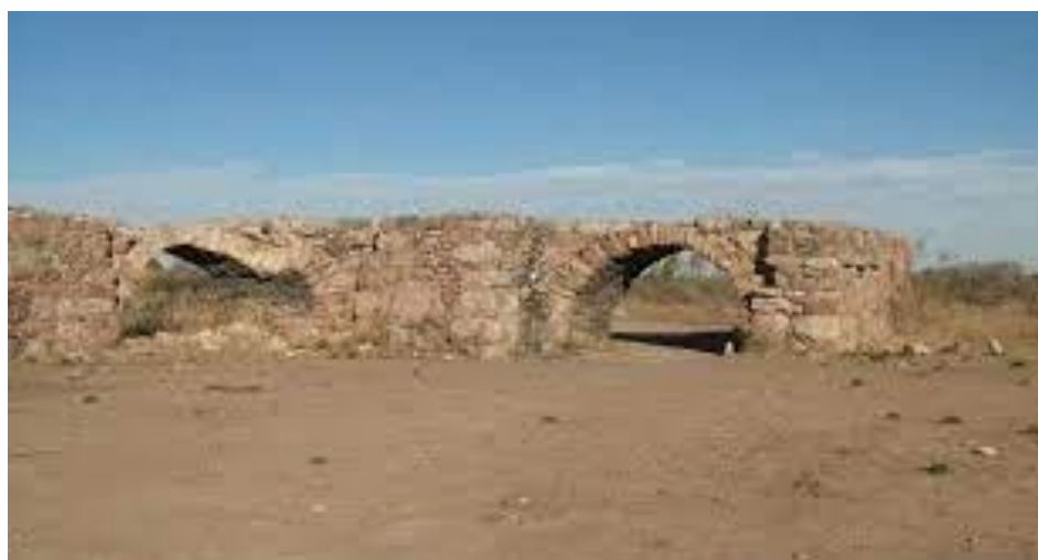
Ilustración 14. Dique Toma de los Españoles en Las Compuertas. Fuente: Logia Petit Verdot 14 .
