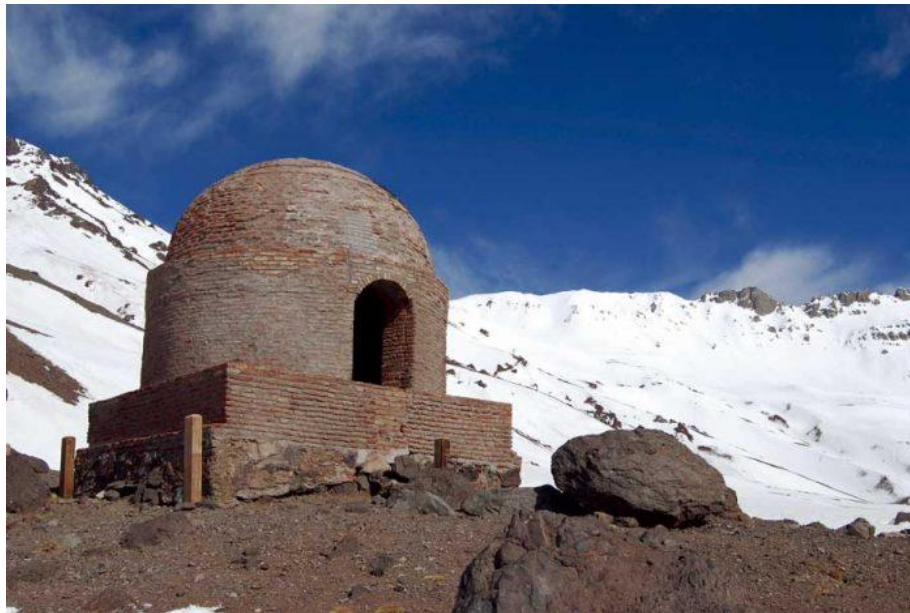
Ilustración 10. Fotografía de construcción arqueológica en Vías Panorámicas Casuchas del Rey. Fuente: Gobierno de Mendoza 11 .
